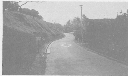
見通しの効かない狭い道（改修前）
