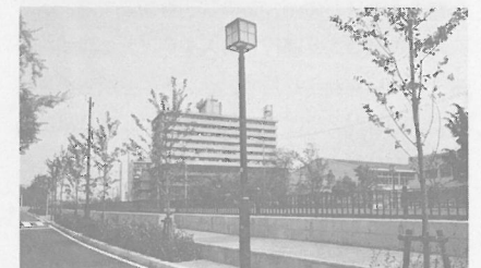
視覚的広がりを与える二段歩道（井土ヶ谷橋下流）
