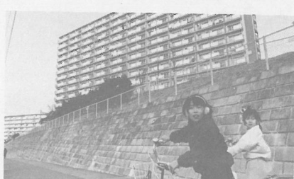
高層住宅団地の高く連なる擁壁(港南台)
