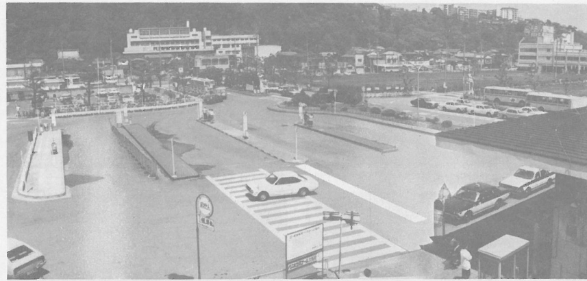
駅前広場全景(改修前・駅側よりみる)
