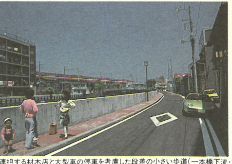
運担する材木店と大型車の停車を考慮した段差の小さい歩道(一本橋下流・右岸)
