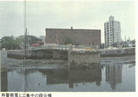
寿警察署と工事中の段谷橋
