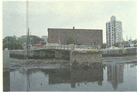
寿警察署と工事中の段谷橋
