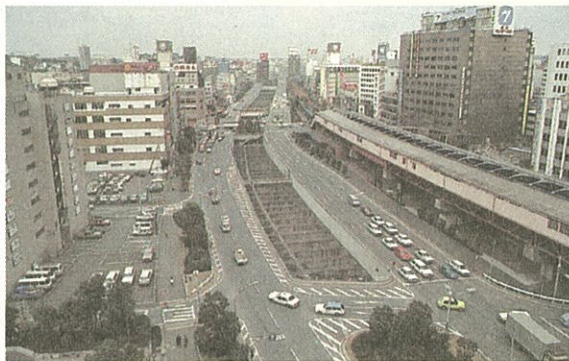
地下化した高速道路 Expressways go underground
