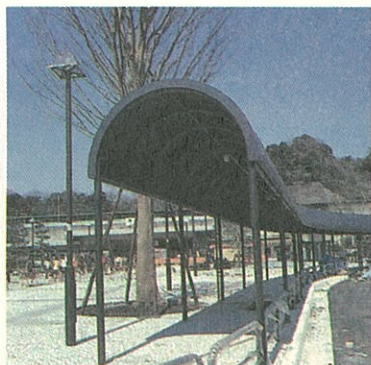
バス停留所屋根(本郷台駅) Bus Stop Shelter (Hongodai Station)
