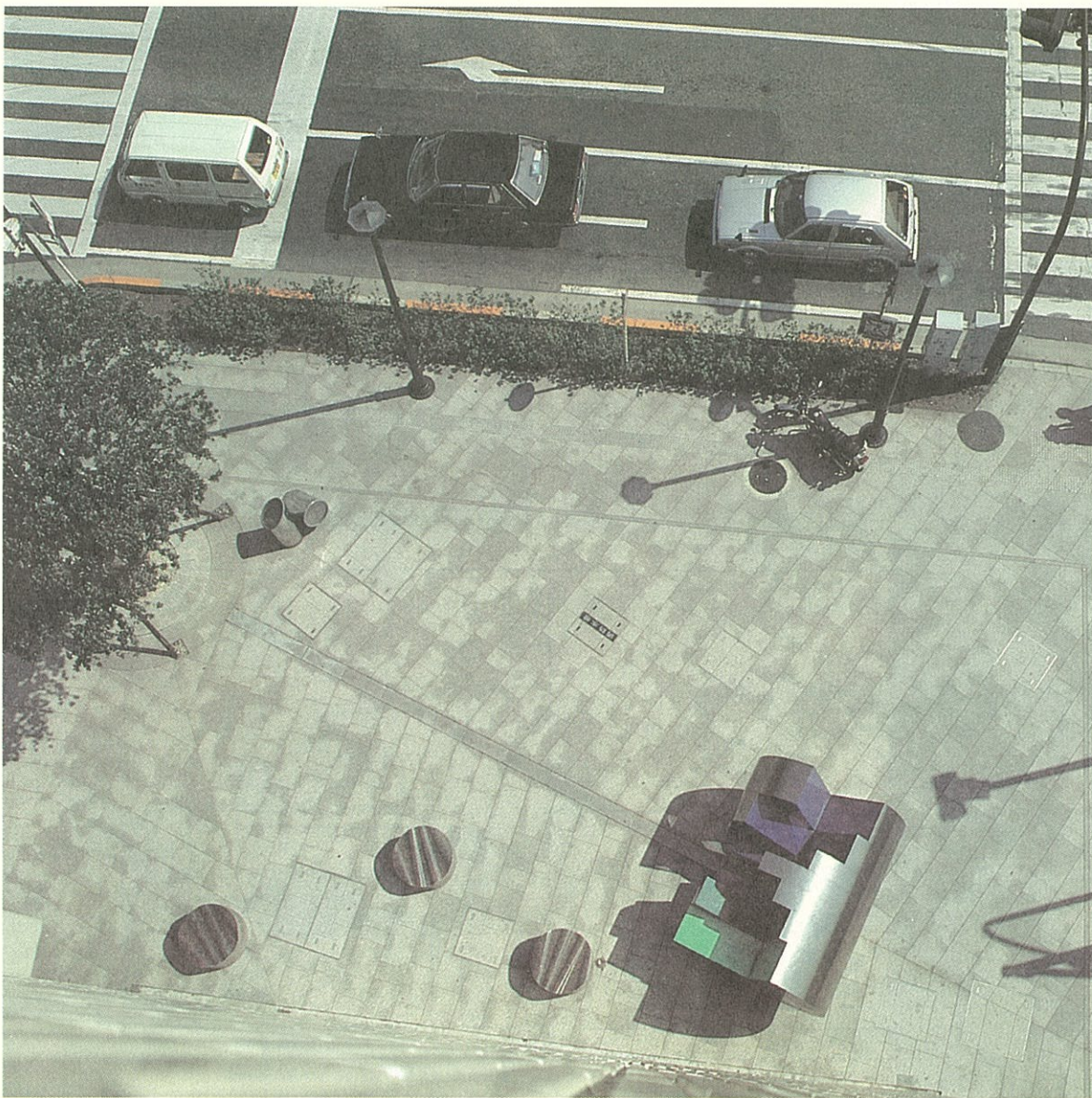
横浜市健康福祉センター Yokohama Health and Welfare Center
