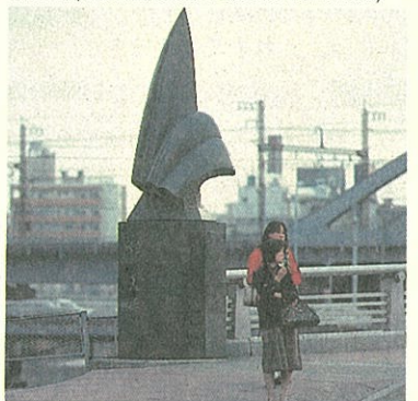
橋(弁天橋) Bridge (Bentenbashi)
