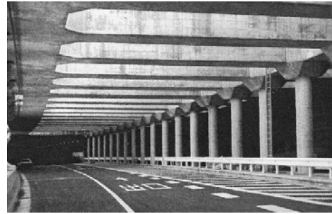
Fig. 15 Scene of undergrounded motorway, Source: Bibliography 37 図 15 首都高横浜公園付近の半地下部(掘割部) 出典: 参考文献 37
