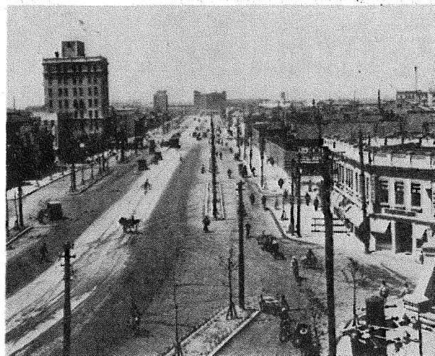
竣工した御堂筋北部
