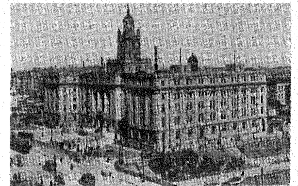
竣工時の中之島市庁舎
