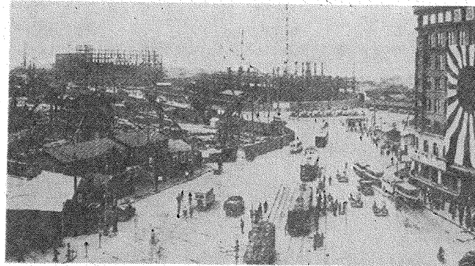
工事中の大阪駅と駅前区画整理事業
