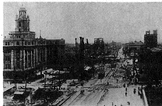
工事中の市庁舎前
